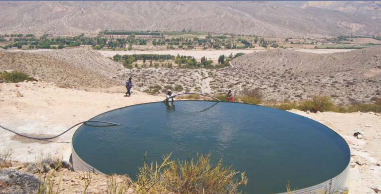
Tanque Australiano, El Perchel, Jujuy
